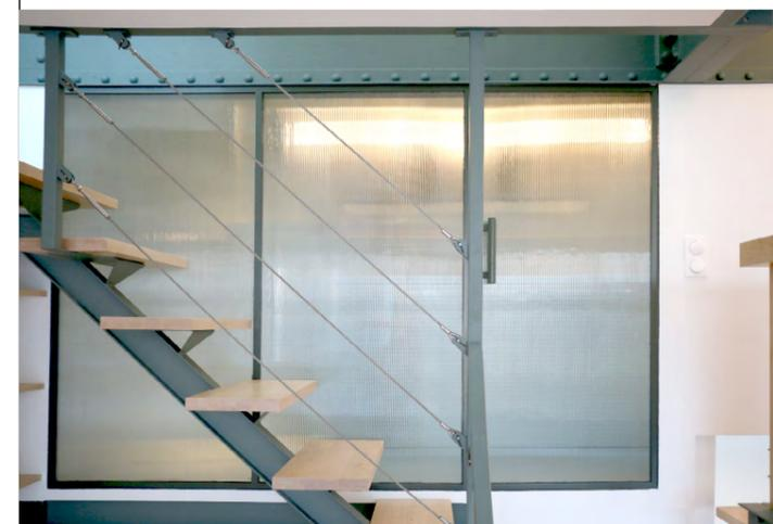
L'espace est structuré par deux mezzanines suspendues sur lesquelles se trouvent le bureau et la chambre. Entre les deux, à mi-hauteur dans l'espace, se situe la salle de bain, protégée des regards mais pas de la lumière par un vitrage structuré. Murs, sols et meubles sont carrelés d'une délicate pâte de verre.
